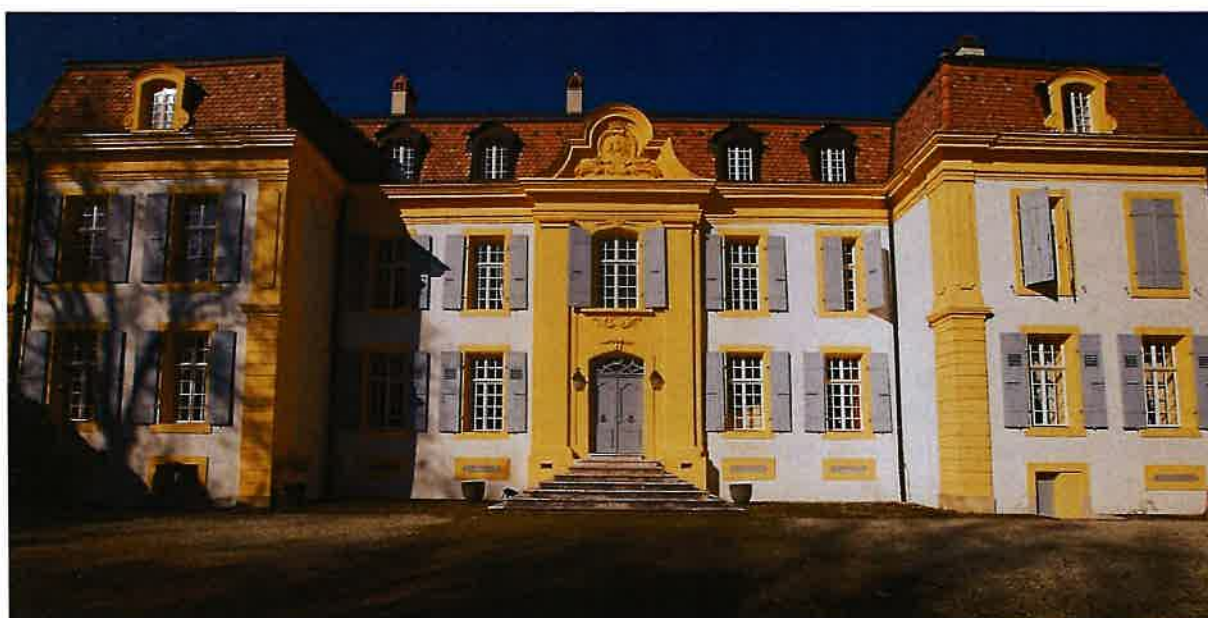
Façade Est entrée principale
